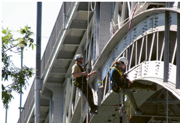
1 Arbeiten am Seil erfolgen immer mit Arbeits- und Sicherungsseil.
