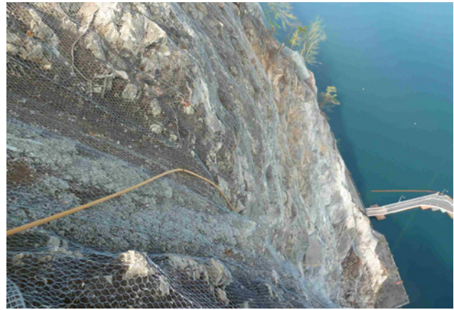
3 Risiken wie Lawinen und Steinschlag sind bei Arbeiten im Bereich von Naturgefahren ständig neu zu beurteilen.
